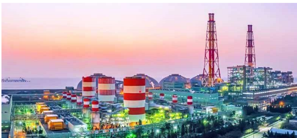
興達發電廠 位於高雄市永安區，1970 年代為供應南臺灣工廠大量的用電需求而建。裝置總容量約為 430 萬瓩，僅次於台中與大潭發電廠，為全台第三大之火力發電廠。
