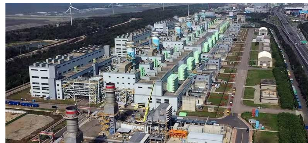
大潭火力電廠 座落於桃園市觀音區，1982 年利用觀音鄉爆發鎢米事件後所荒廢之土地，重新處理、規劃而生。共裝設 6 部最新式高效率複循環機組，使用一次燃料可以發電兩次，是亞洲最大的天然氣複循環發電廠，願這個新生的電廠，繼續為台灣在環保、供電等各方面，都成為其他電廠的標竿，發光發熱，照亮未來。
