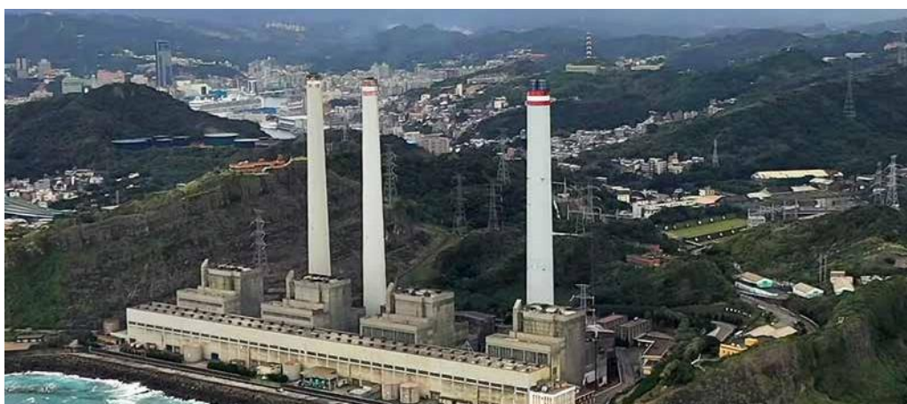
協和發電廠 位於基隆市中山區，1985 年取代北部火力發電廠，是全台唯一僅使用重油作燃料之電廠，同時也是全台第一座開始使用 345kv 輸出之火力發電廠。
