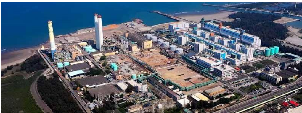
通霄火力電廠 地處苗栗縣通霄鎮，是全台第一座天然氣發電廠，也是第一座使用複循環系統之發電廠，讓「環保電廠」一詞成為現實。
