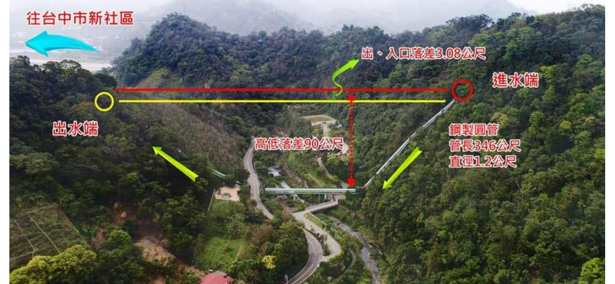
白冷圳抽藤坑的白冷圳 2 號倒虹吸管，長 346 公尺，高低落差 90 公尺，直徑 1.2 公尺，以虹吸原理設計的倒虹吸管鋼製圓管沿著山坡攀附，工程極為艱難，是遠東地區最長的虹吸式導水管。
