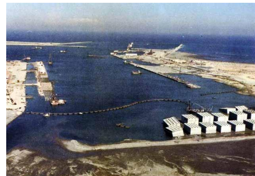
台中港第一期工程一至三號碼頭係一沉箱式碼頭，所需沉箱全部在沙灘製作，1974年共完成23座。（圖／榮工處提供）
